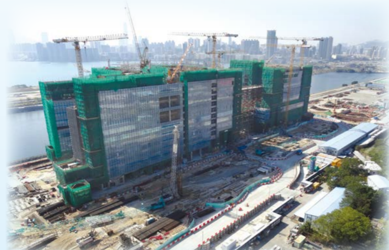
興建中的香港兒童醫院 The HKCH under construction
