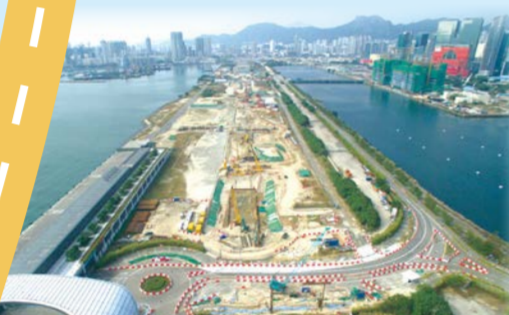
進行中的第二期基礎設施工程 Stage 2 infrastructure works under construction
