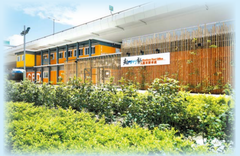
位於觀塘繞道下的起動九龍東辦事處臨時辦公室 The temporary office of EKEO underneath Kwun Tong Bypass
